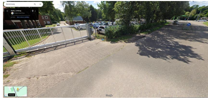
Bestaande situatie hoofdentree vanaf de Beckersweg
