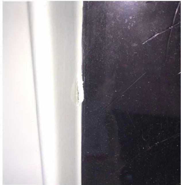
Beglazing woning, afgewerkt met siliconen kit
