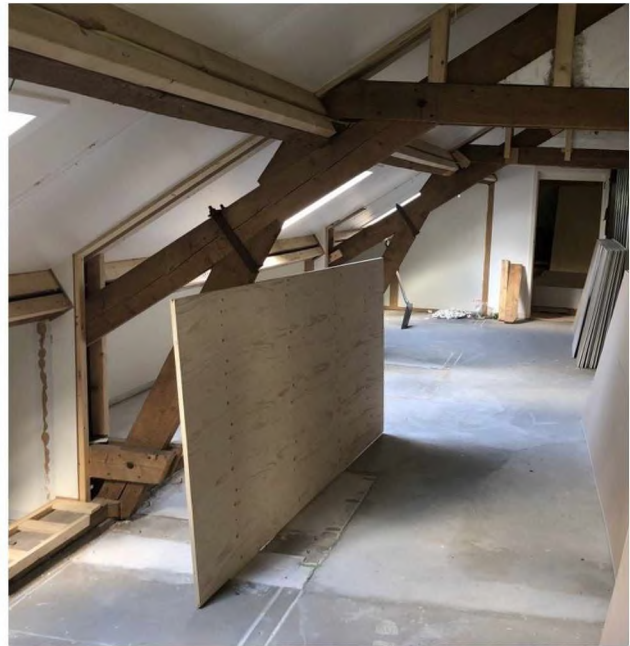
In aanbouw zijnde kamers
