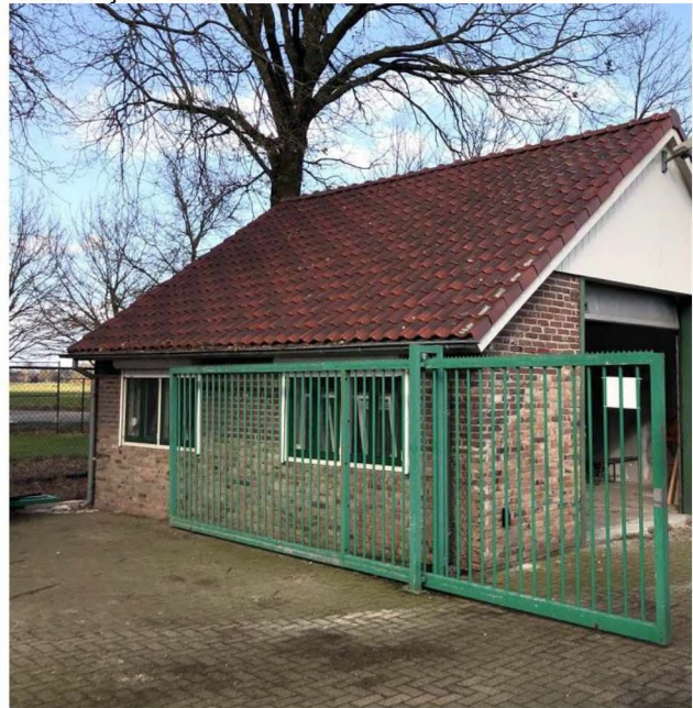
Voorzijde gymzaal, kozijnen met asbestverdachte kit
