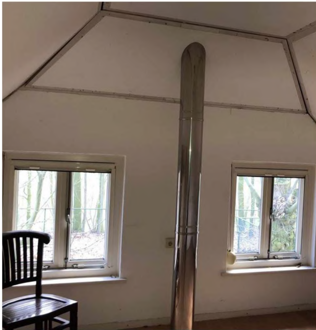
In aanbouw zijnde kamers
