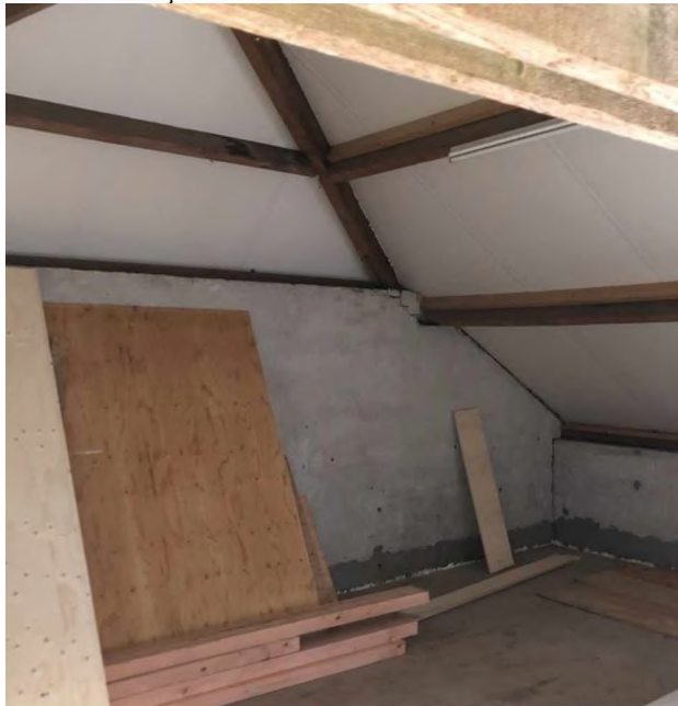
In aanbouw zijnde kamers
